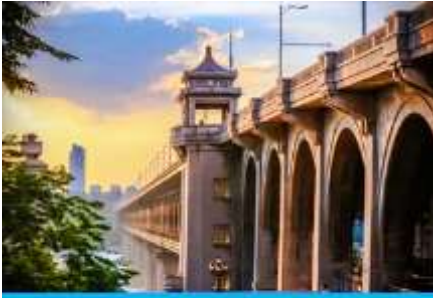
สะพานข้ามแม่น้ำหวู่ฮั่น
